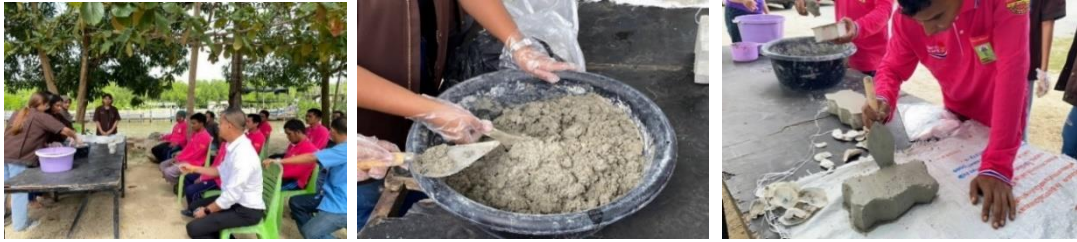
ภาพที่ 4 สาธิตวิธีการและการขึ้นรูปอิฐบล็อก แล้วนำไปตากแดด ที่มา :ภัทรวดี ชุ่มโชติ, วันที่ 16 มกราคม 2567
